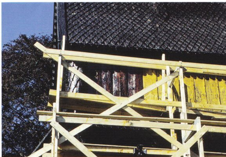
Til venstre: Tjærebreing av Hopperstad stavkirke. Det gjenstår å tjærebre sydveggen på hevet midtrom. Det er en tydelig forskjell på før og etter behandling. Bildet over viser samme veggen under tjærebreing. Foto: I. M. Egenberg.
