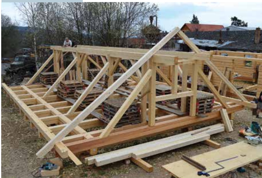
Sundání vrchních pater roubení na zem a stavba krovu
