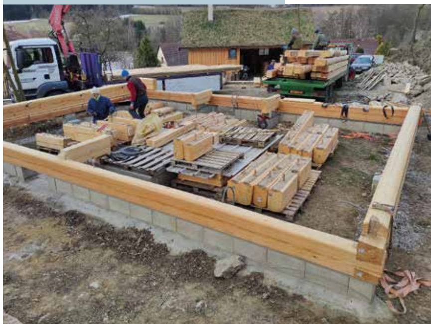
Montáž – izolování a opětovné skládání roubenky
